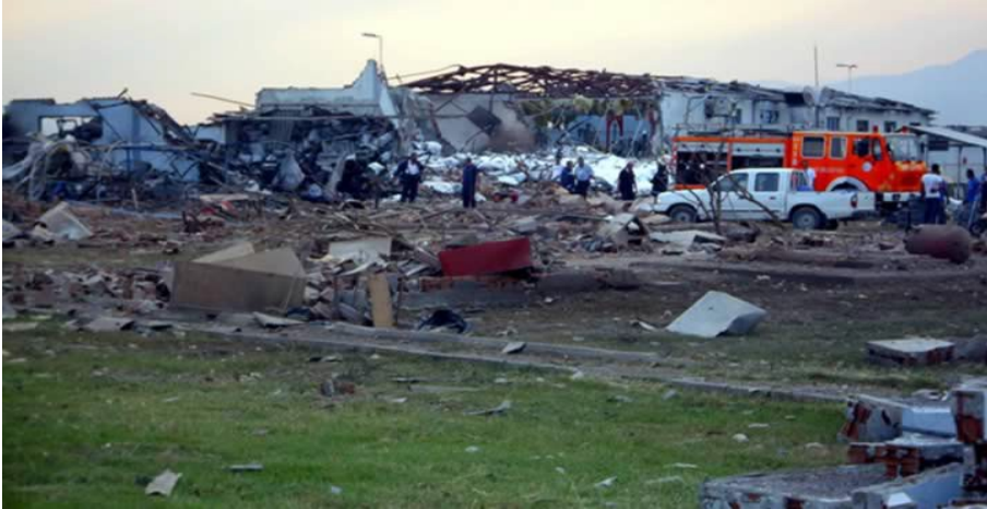
Resim 8: Havai Fişek Fabrikası Patlama Sonrası Bina Enkazı
