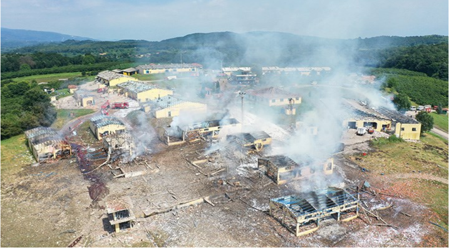
Resim 5: Sakarya Hendek de bulunan havai Fişek Fabrika Patlama Sonrası Kaynak : tr.sputniknews.com “sakaryada-havai-fisek-fabrikasında-patlama/”
