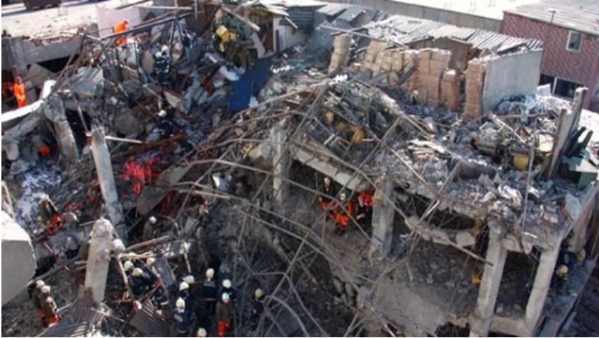
Resim 14: Patlama sonucu İşhanı enkazı
